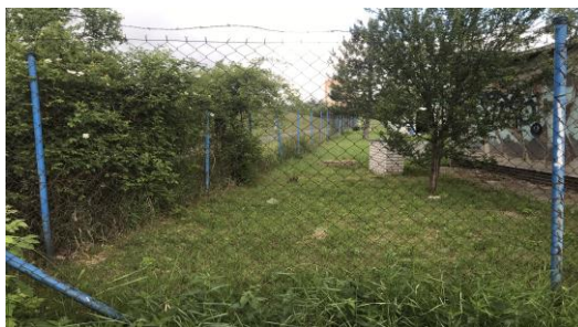
Stávající oplocení foto č 02 / Černý Most II
