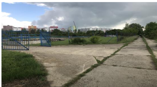
Stávající oplocení foto č 01 / Černý Most II
